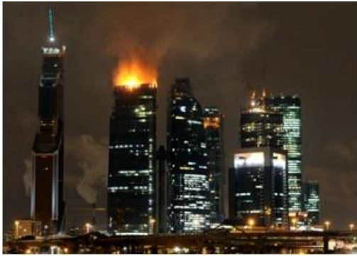
Рис. 5.5. Пожар в башне «Восток»
